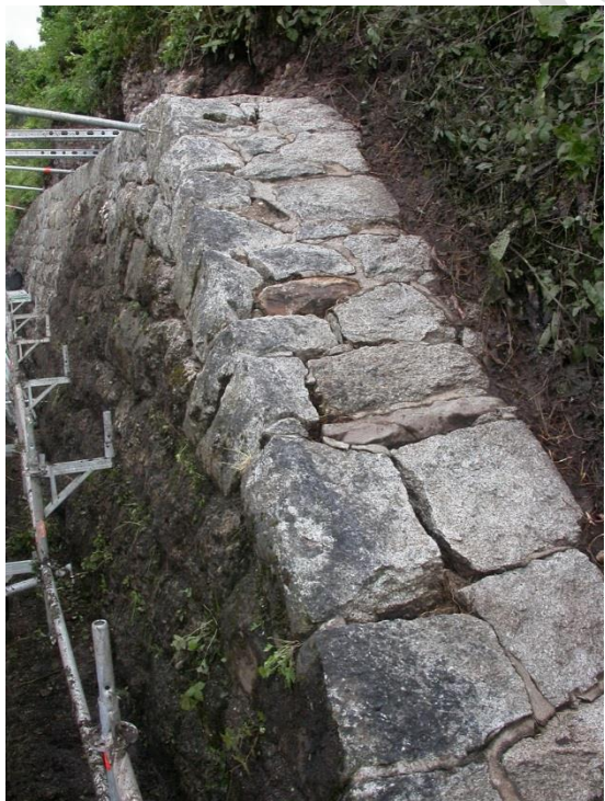
Foto 15: Mauerkrone mit ausgewitterten Fugen
