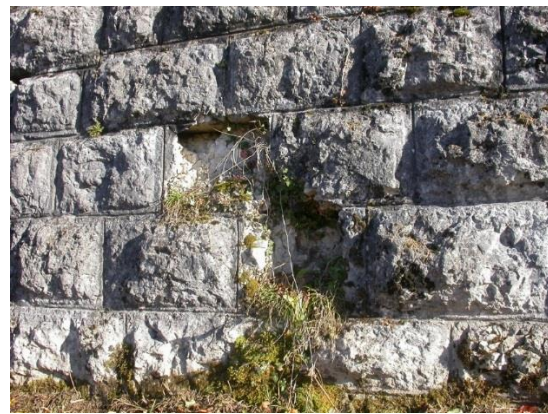
Foto 22: einzelne tief verwitterte Mauersteine (Bröckelzerfall von Kalkstein)
