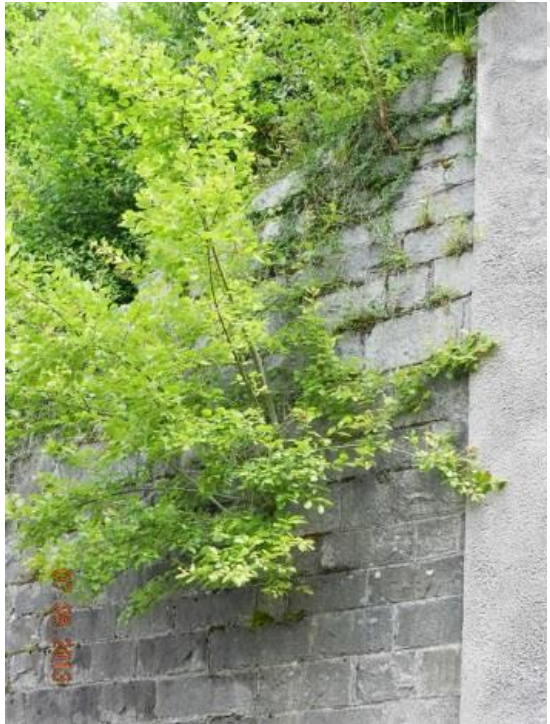
Foto 7: starker, verholzender Bewuchs (mit Schadenfolge)
