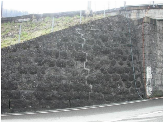
Foto 9: vermutete leichte Verformung, vermörtelter Riss als Indikator
