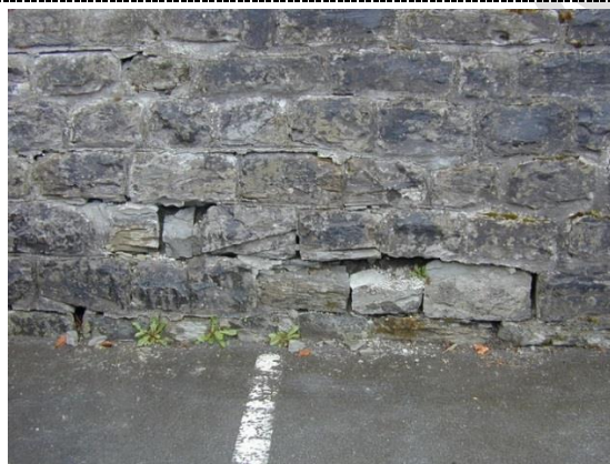
Foto 21: Absanden von Berner Sandstein (Oberflächenphänomen)
