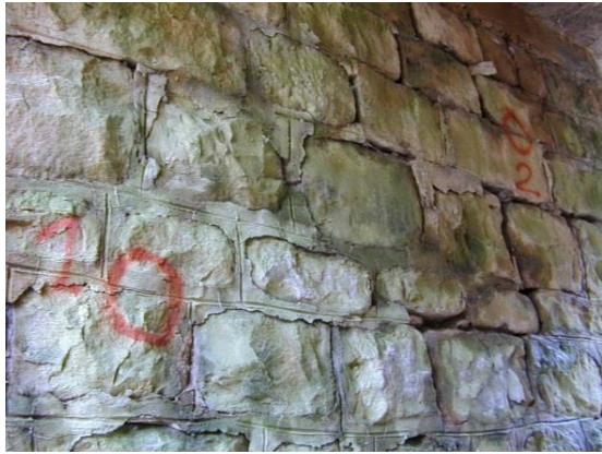
Foto 13: Fugen systematisch abgerissen
