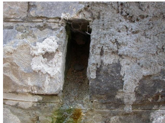
Foto 4: Mörtelschutt in Entlastungsöffnung
