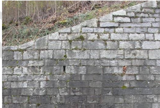
Foto 8: Mauerkrone leicht verschoben
