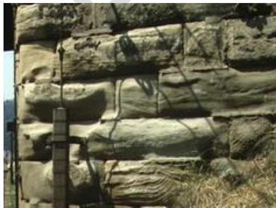
Foto 21: Absanden von Berner Sandstein (Oberflächenphänomen)
